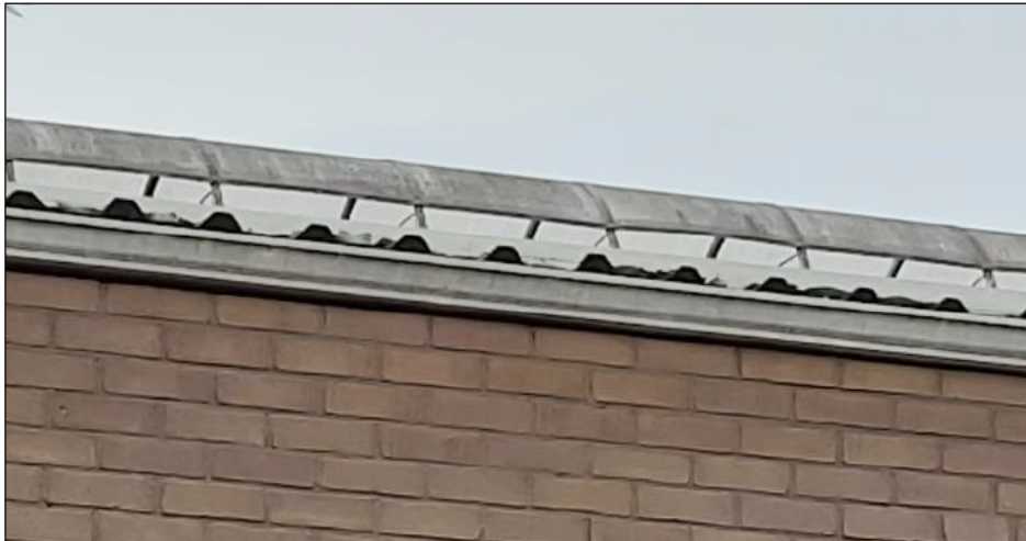
Afbeelding 4 Open nok stal 2 in 2001 en 2020
